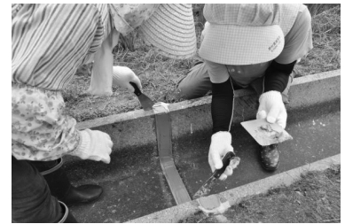
長持ち目地補修
