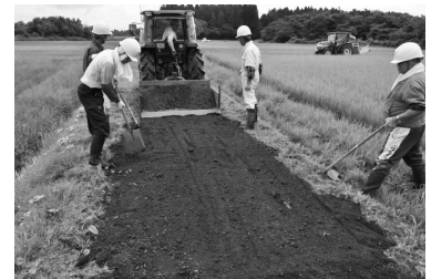
農道の補修・整備
