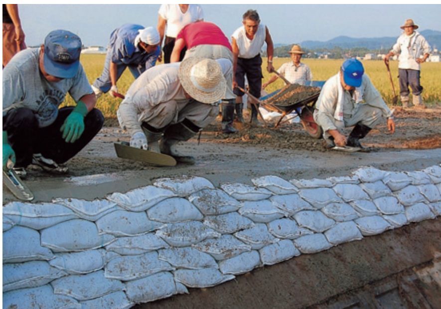
土のうを積んだ上を、10～15cmの厚さに コンクリートで平らに塗り固める
