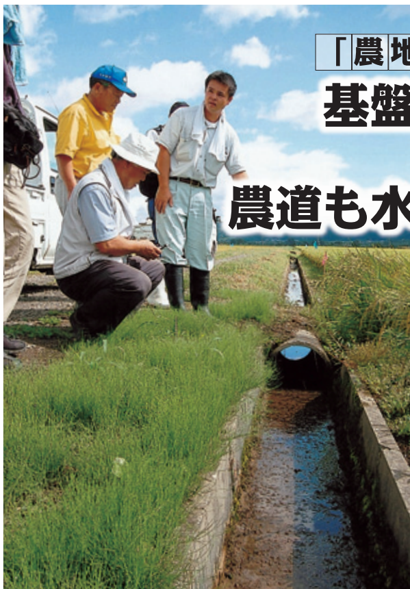
水路の補修が必要な箇所を点検
