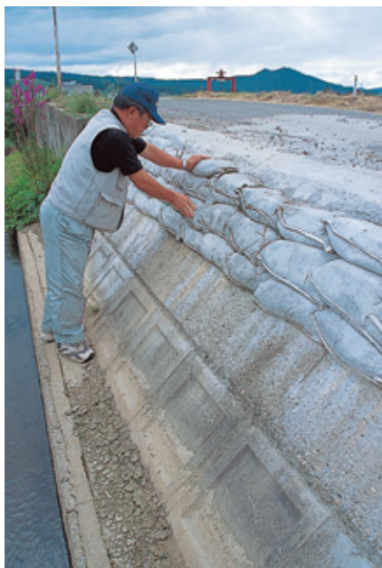
1年後、カチカチに固まった土のうはびくと もしない。袋自体は次第に風化していくが、 全体が固まっているので問題ない
