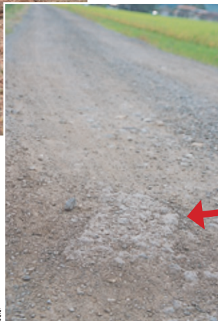
1年後、アスファルトが固まった状態
